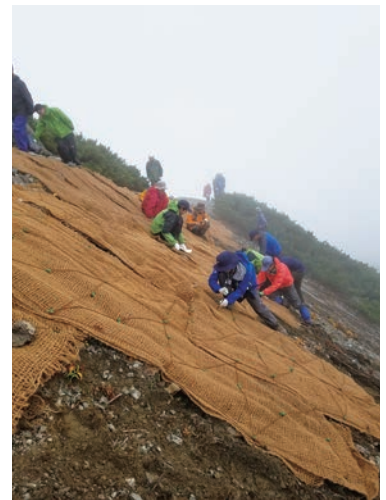
ヤシマットの設置作業
